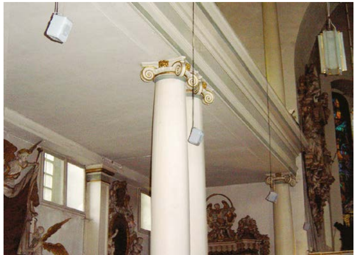
◀ ▲ Installation der Beschallungstechnik in der Friedenskirche in Jena im Rahmen der Kulturarena 2003.
